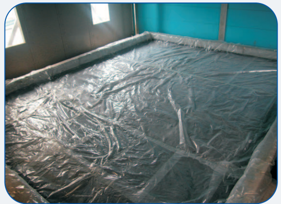
安装0.1毫米厚防水薄膜
